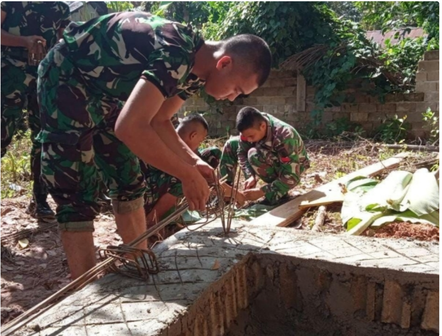
Pengerjaan Rehab Kamar Mandi dan WC Mushola Nurul Iman Capai 40%
